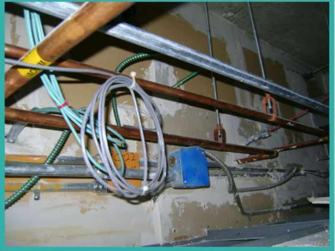
Puntos de infiltración sellados.
